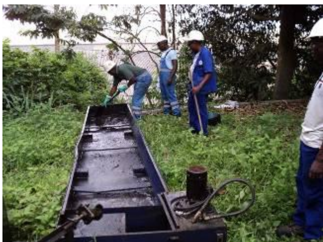
Bild 21: Wasserbehälter werden gereinigt.
