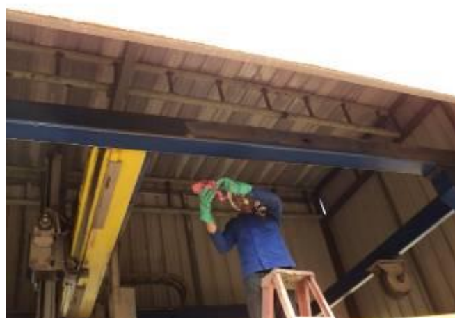
Bild 6: Nach den Vorschriften im Camp, muss der Gerüstbauer ein Gerüst hinstellen, weil über 1,8 Meter ab Boden nur mit Gerüst gearbeitet werden darf. Wenn kein Gerüstbauer kommt und die Maschine dringend benötigt wird, wählt Alternativen.
