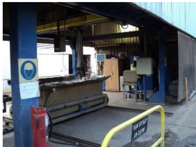
Bild 5: Jetzt haben wir den Service gemacht, weil zuviel Sand auf die Laufrollenführung und den Zahnstangen Antrieb kam, was unruhige Bewegungen verursachte.
