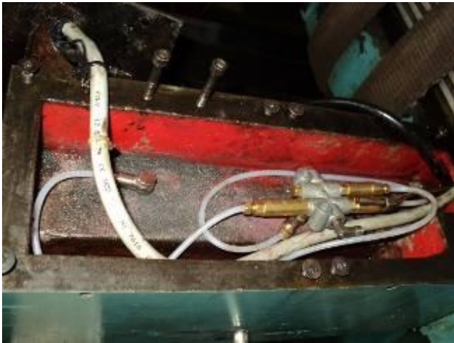
Bild 33: Der neue Ölverteiler mit den 2 Dossiereinheiten. 2 Stück Typ 16 Schmierstellen und einmal eine Typ 10 er.
