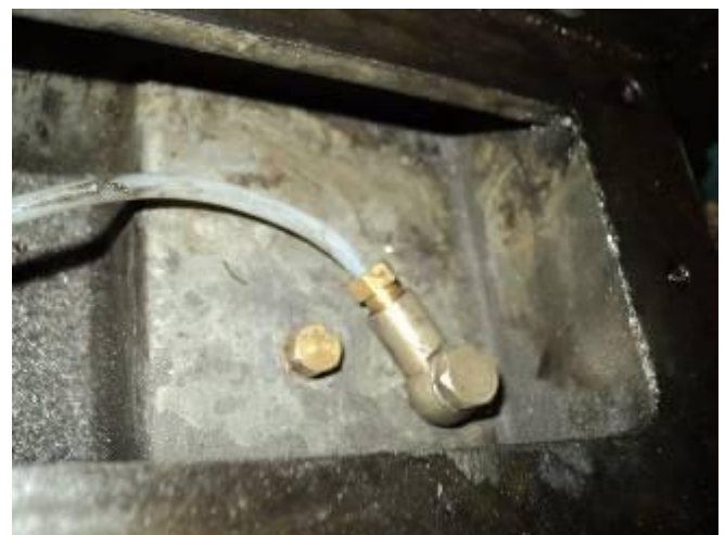
Bild 32: Es wurden neue Löcher gebohrt, welche die Führungen mit Oel versorgen.
