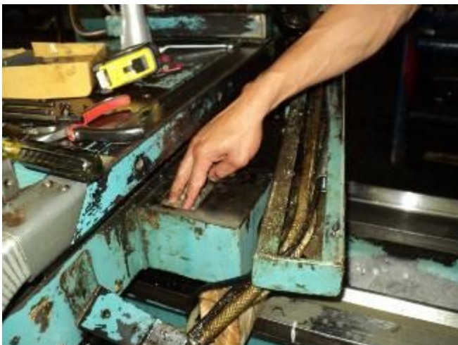
Bild 29: Dies war die alte Oelstelle vom alten konventionellen System. Sicher 2 Liter Oel war darin und hat zur alten Zeit selber geschmiert. Aber mit dem Bau als CNC Maschine wurden diese alten Schmiervarianten nicht mehr genutzt. Es wurde an die Zentralschmierung angehängt. Dafür sind jetzt diese alten Oelbehälter voll alter Emulsion.
