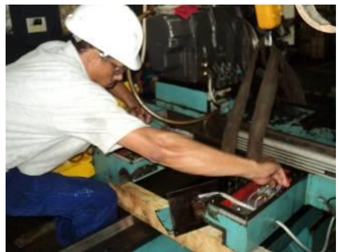
Bild 31: Carlo installiert die neuen Schmierleitungen
