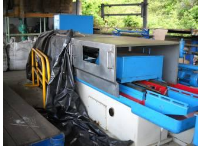
Bild 7: Diese Tiefbohrmaschine wird normal abgedeckt wenn sie nicht arbeitet muss. Wenn der Wind jedoch die Abdeckung wegbläst und es eine Woche offen bleibt, frisst der Rost an den Führungen.
