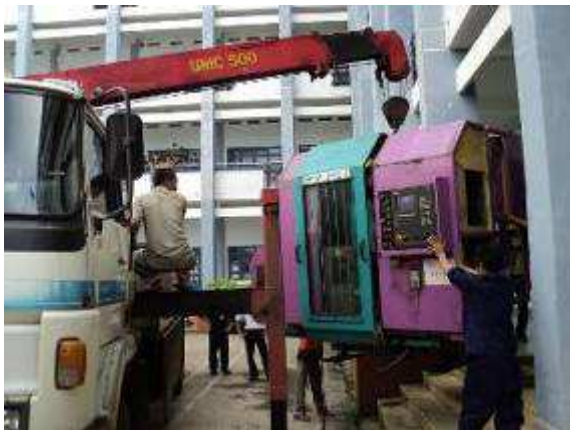
Photo 8b: Hier hebt man mit einem 7 Tonnen Kran die 5 Tonnen Maschine.
