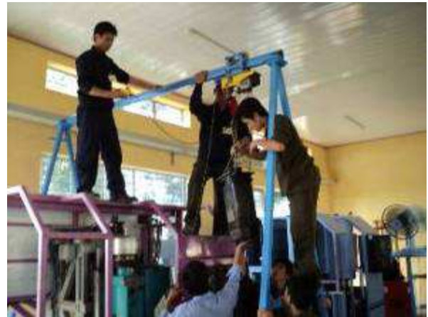
Photo 8d: Der neue, selbstgebaute, kleine Kran tut sein Dienst. Es wird alles zerlegt und wieder montiert..
