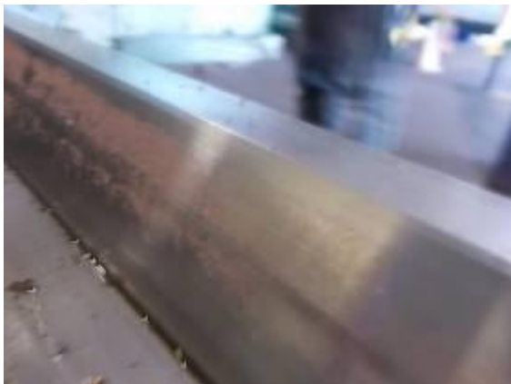
Bild 73) Der Rost ist ein grosses Problem in Angola.
