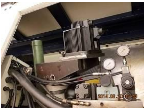
Bild 4) Anbau vom X Motor. Eine sehr komplizierte Konstruktion, weil wir wenig Platz haben.
