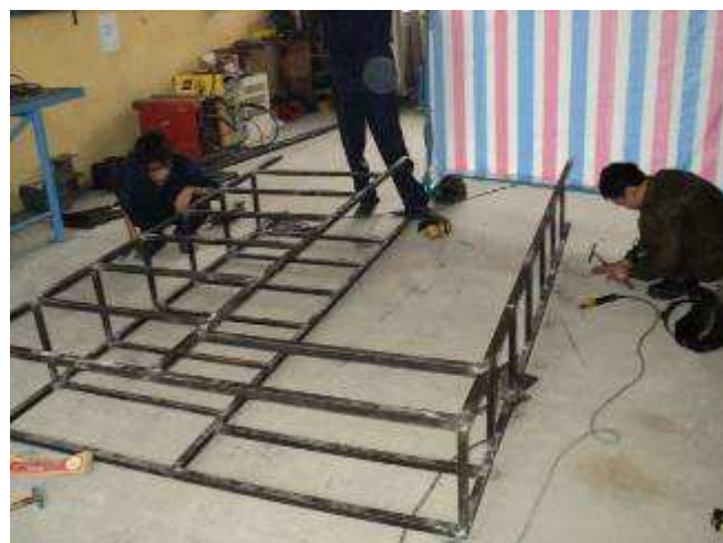
Photo 22: Hier schweisst man noch an der Absperung für das Schraubenlager.
