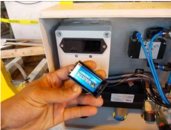
P63: A battery unterstütztes system. 2 batteries
